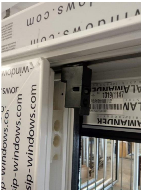
Rys.... Demontaż wieszaka.
