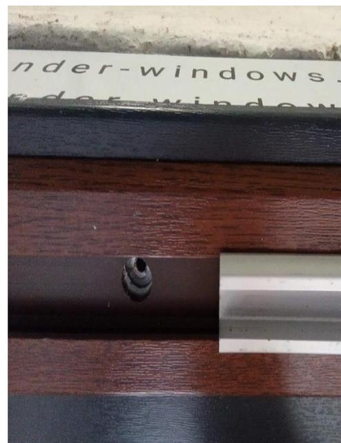
Abb. Dübelloch unter der oberen
