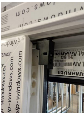
Obr.... Demontáž závesu. koľajničkou.
