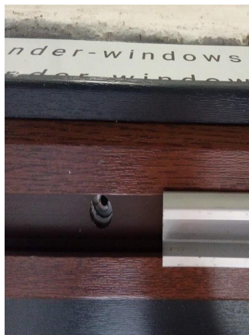
Obr... Otvor pre hmoždinku pod hornou koľajničkou.
