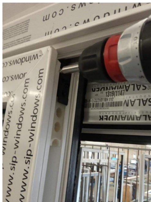
Rys.... Demontaż maskownicy skrzydła. Rys... Odkręcenie śruby mocującej wieszak.
