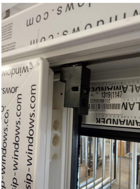
Rys.... Demontaż wieszaka.
