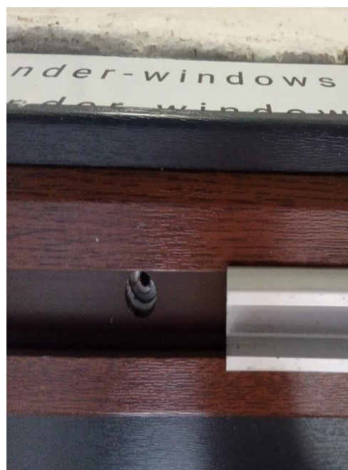
Rys... Otwór na dybel pod górną szyną.
