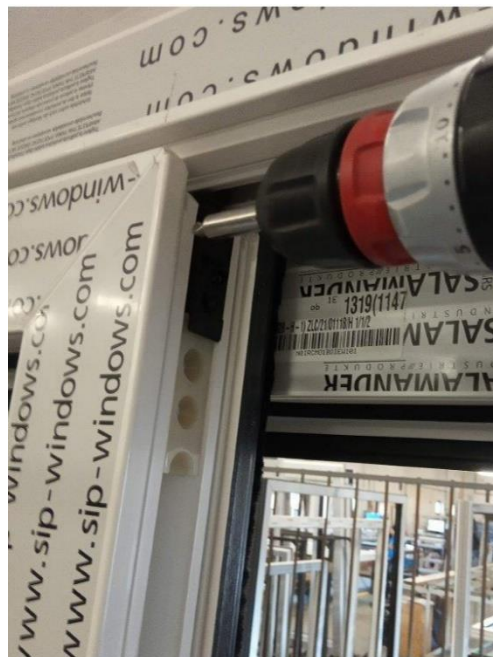
Obr.... Demontáž krycej lišty krídla. Obr... Odskrutkovanie upevňovacej skrutky závesu.
